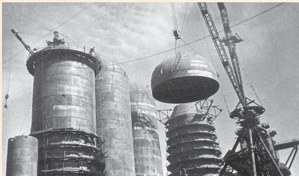
Строительство шестой доменной печи в Магнитогорске, 1943
